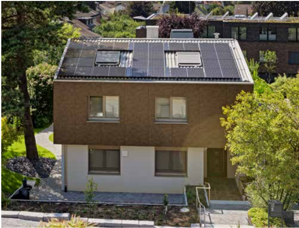
PHOTOVOLTAIKANLAGE, DÄMMUNG, HEIZUNG – FAMILIE ZIMMERMANN HAT IHR HAUS UMFANGREICH ENERGETISCH RENOVIERT. FOTO: DANIEL DESBOROUGH
