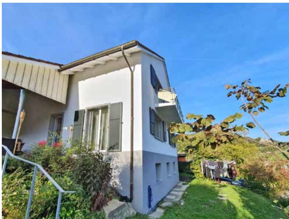
VORHER UND NACHHER: DIE LIEGENSCHAFT IM HERBST 2020 VOR DER SANIERUNG UND EIN JAHR SPÄTER MIT NEUER FASSADENDÄMMUNG. FOTOS ZVG
