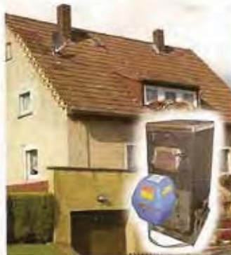
Unisoliertes Haus Alter Ölkessel Jahresverbrauch: 22 Liter/m 2
