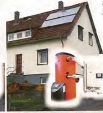
Isoliertes Haus/Neuer Ölbrennwertkessel/Solaranlage Jahresverbrauch: 5 Liter/m 2
